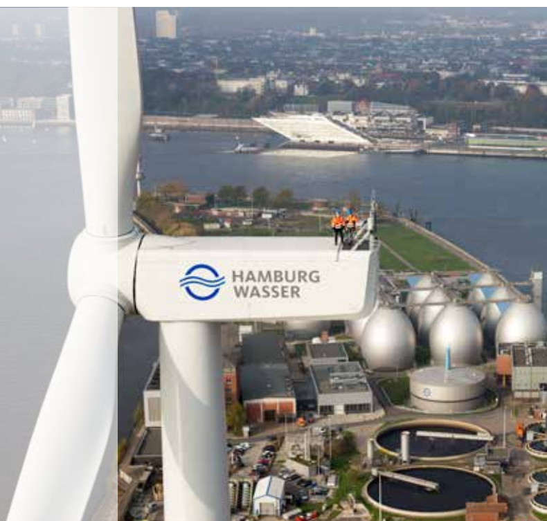
Abbildung 14: Die neue Windenergieanlage auf Köhlbrandhöft
