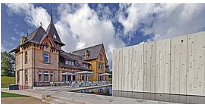
Außenansicht der Wasserkunst Elbinsel
