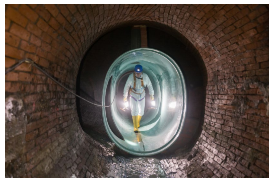
Abbildung 1: Rohrling-Verfahren in der Danziger Straße (Foto: Ulrich Perrey/HW)
