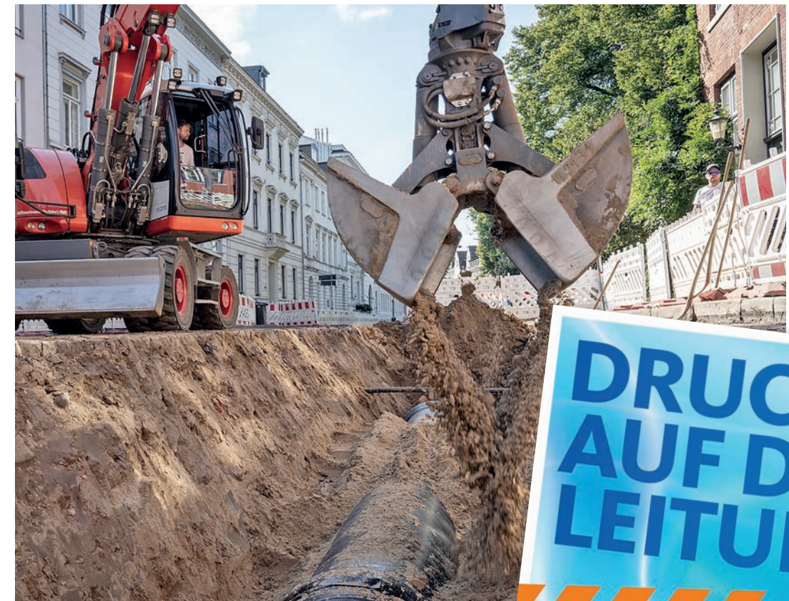
Sichere Versorgung für den Hamburger Westen: Als Gesamtprojektleiter des zweiten Bauabschnitts kümmern wir uns in Elbchaussee aktuell nicht nur um rund 120 Jahre alte Trinkwasserleitungen, sondern koordinieren die gesamten Bautätigkeiten des Kooperationsprojekts (Foto: Thomas Ebert / HW)
