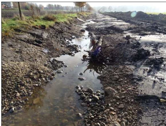
Foto 2: Einbau von größerem Substrat und Totholz (Foto: M. Nickel)
