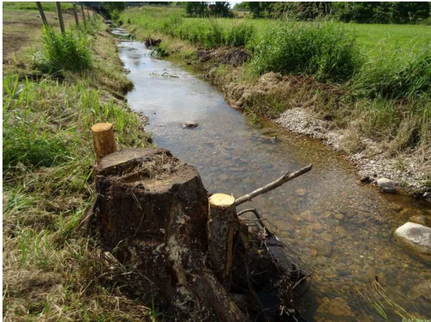
Foto 2: Einbau von Totholz und Kiesschüttungen (Foto: M. Nickel)
