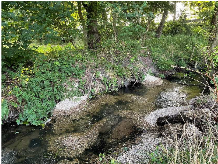
Foto 4: Einbau von Hartsubstraten in das Bachbett der Este (Aufnahme: U. Meertens, Juli 2025)
