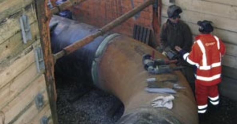
liche Maßnahmen im Versorgungsgebiet vorgenommen werden, um die Versorgung während der Arbeiten auf der südlichen Elbseite sicher zu stellen. Unter anderem wurden für das Pumpwerk „Neuer Pferdemarkt“ Leitungsneu- und -umlegungen der Dimensionen DN 600 und DN 800 durchgeführt. Trotz der Komplexität konnten die ehrgeizigen Terminvorgaben eingehalten und die Trinkwasserversorgung ohne Einschränkung für unsere Kunden aufrechterhalten werden.
