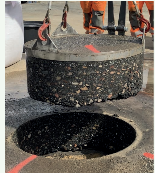
Abbildung 3-27: Keyhole-Verfahren in der Anwendung bei HAMBURG WASSER
