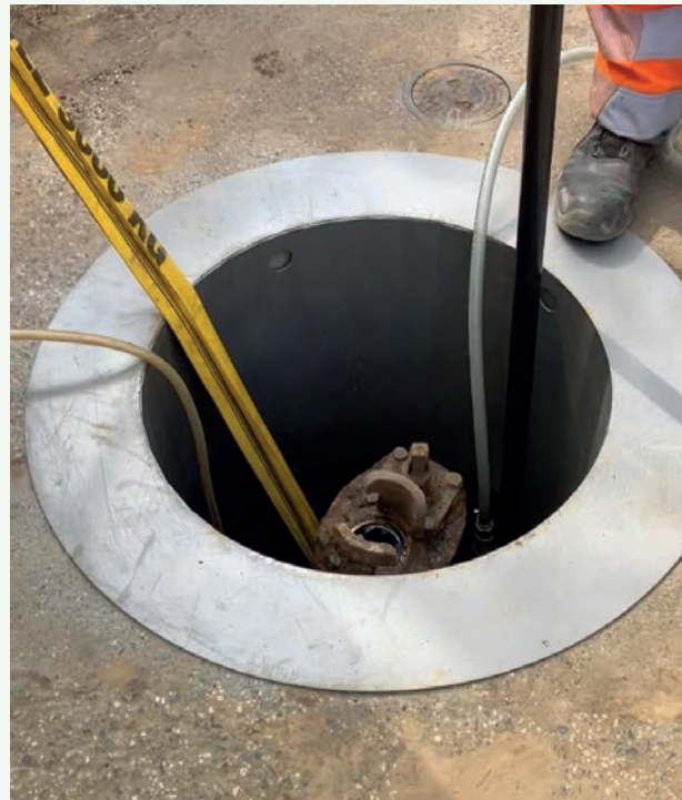
Abbildung 3-27: Keyhole-Verfahren in der Anwendung bei HAMBURG WASSER
