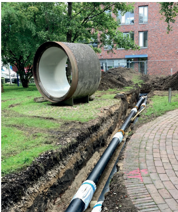
Abbildung 3-18: Baustelle Fernwärmeanschluss
