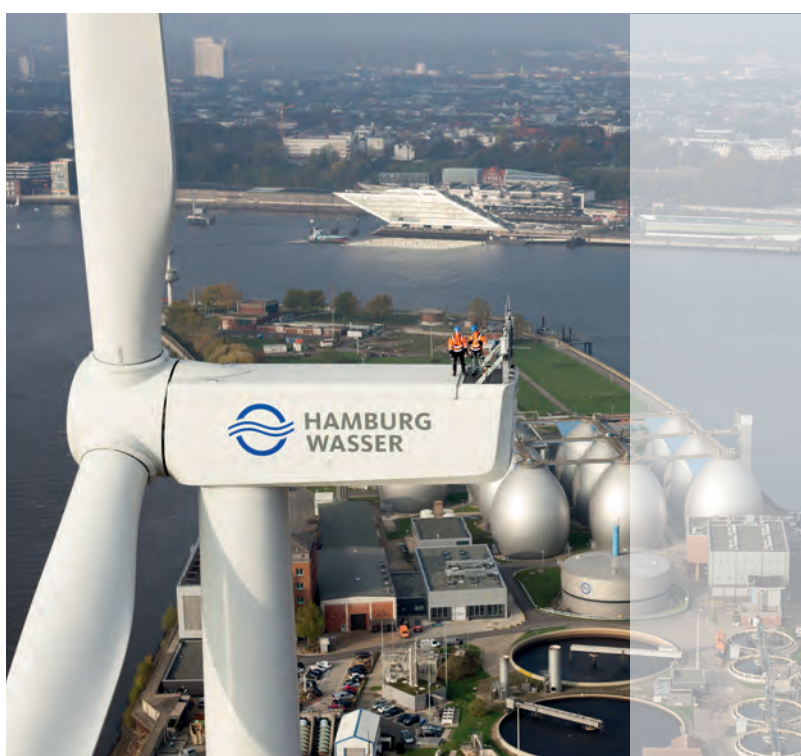
Abbildung 28: Die neue Windenergieanlage auf Köhlbrandhöft
