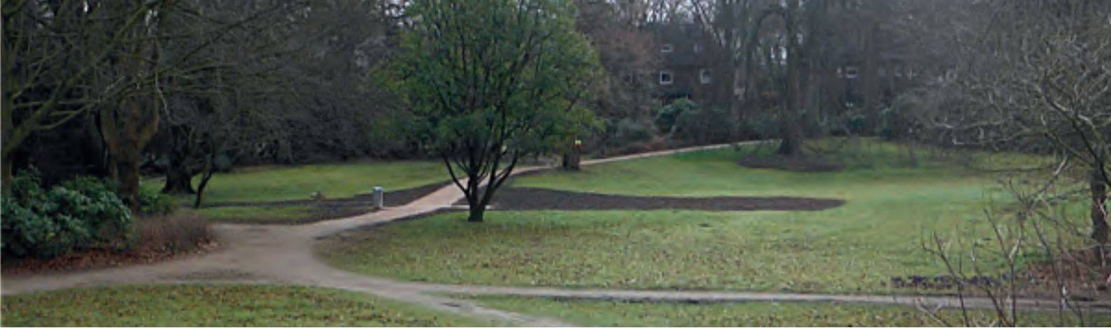
Abbildung 18: Natürliche Mulde im Ohlendorffs Park zur Zwischenspeicherung und Versickerung des überschüssigen Regenwassers
