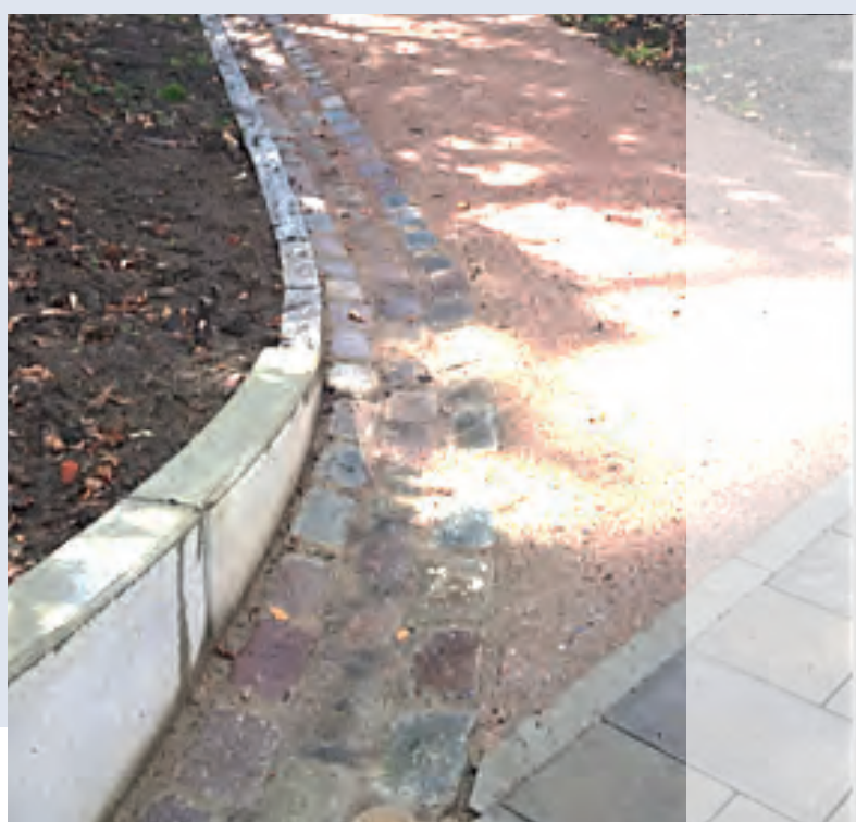
Abbildung 19: Notwasserüberlauf zur Ableitung überschüssigen Regenwassers von der Straße in den Ohlendorffs Park
