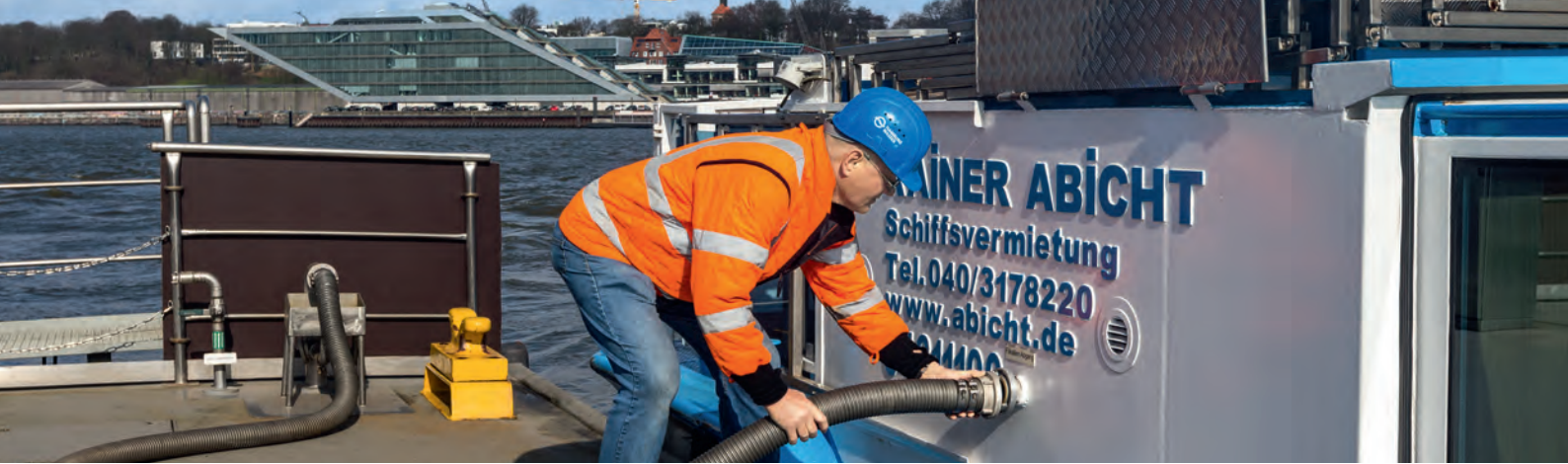
Abbildung 22: Schiffswasserannahmestelle des Klärwerks Hamburg
