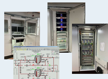
Netzwerkschrank und Bedienstation Netzleitsystem (Vivavis)
