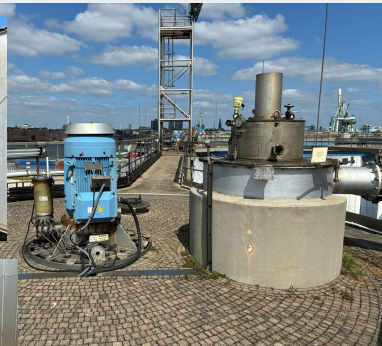
Externe Umwälzung (Mischer) mit Ortsteuerstelle (Ex)
